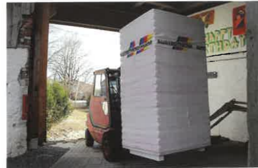
30 Kubikmeter Austrotherm Bodendämmung
